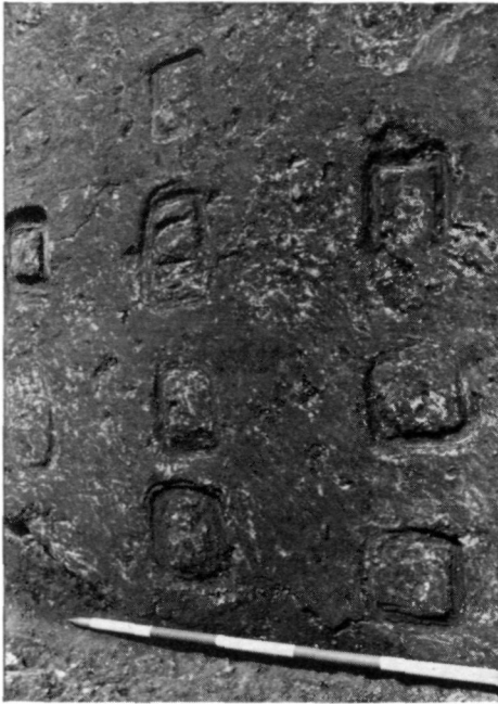
Abb. 5: SG 1/72 – Hypokaustsohle von HBb 1; Abdrücke der als Suspensurpfeilern verwendeten Tubuli.
