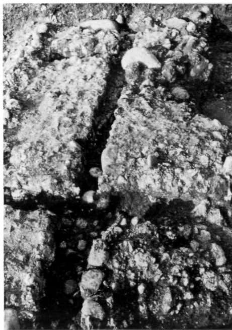
Abb. 14: Detail der umgestürzten Fachwerkwand – das Negativ der sich kreuzenden Holzkonstruktion.
