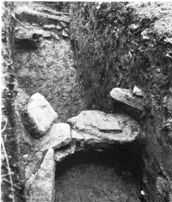
Abb. 3: Schnitt 3 – obere Mauer mit Queranker, im Hintergrund untere Trockenmauer.
