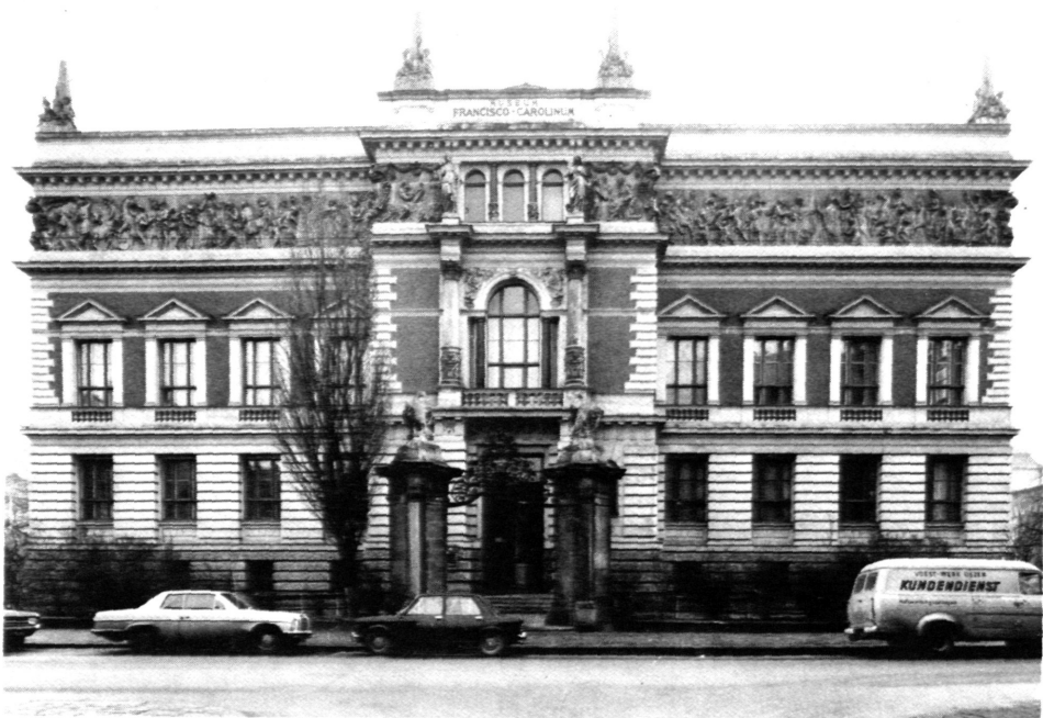
Abb. 2: Ansicht von N, Zustand vor der Restaurierung von 1982/83.
