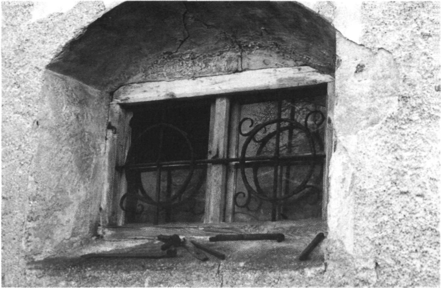
3) Mairhof Nr. 4, Erdgeschoßfenster an der Nordfront (Zustand 1996)
