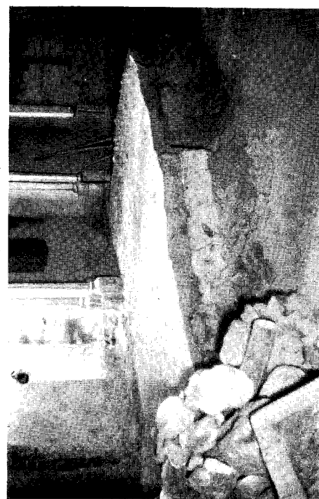
Abb. 11. Der gotische Bogen nach dem Abbruch des barocken Korbhogens (zu Seite 39)
