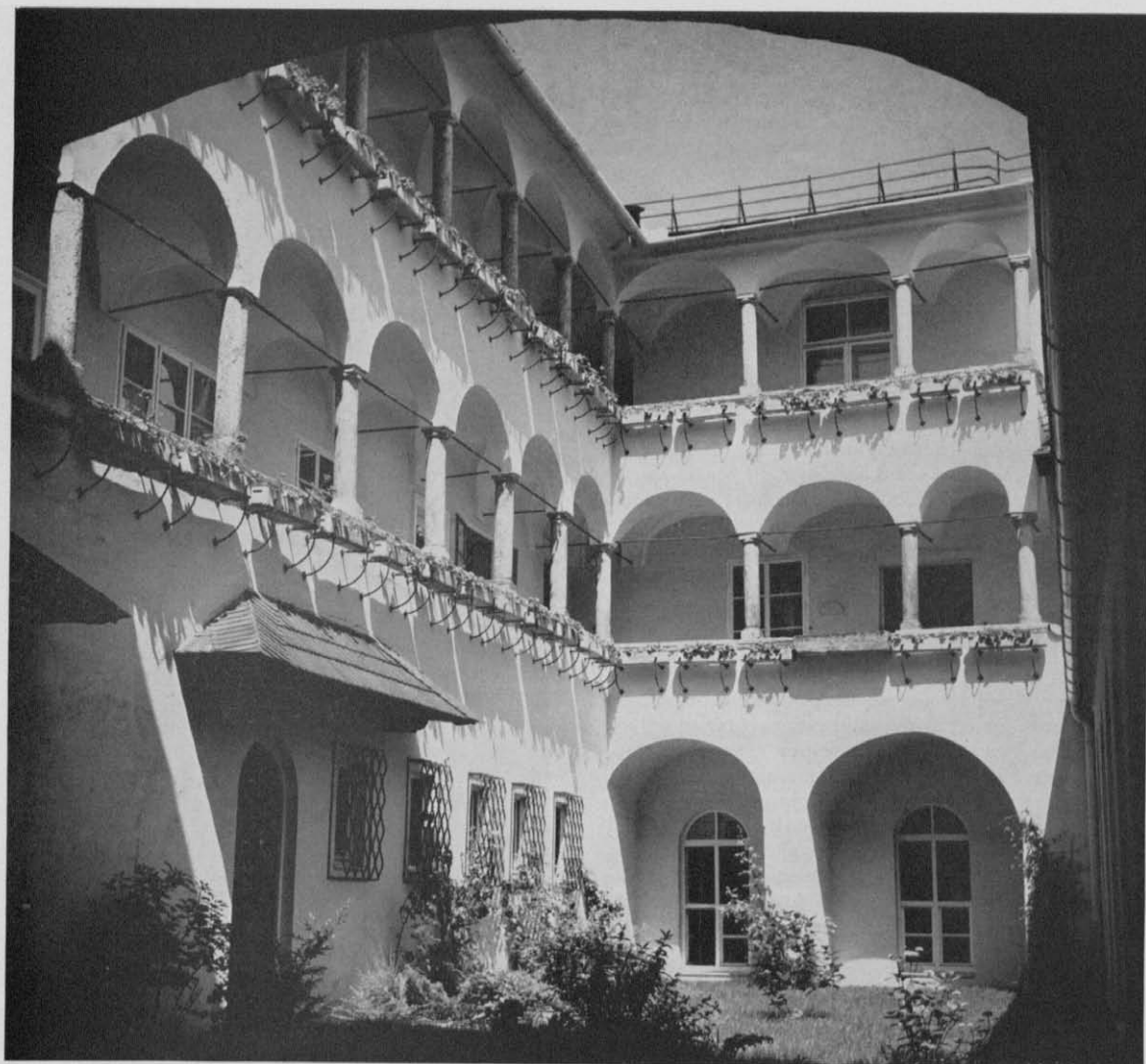
Hof des Hauses Stadtplatz 34, (16. Jh.). Beispielhafte Wiederherstellung 1961
