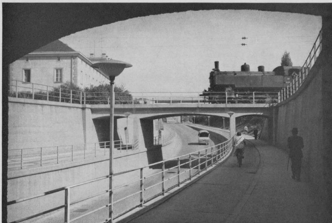
Die Unterführung in die Vogelweidesiedlung
