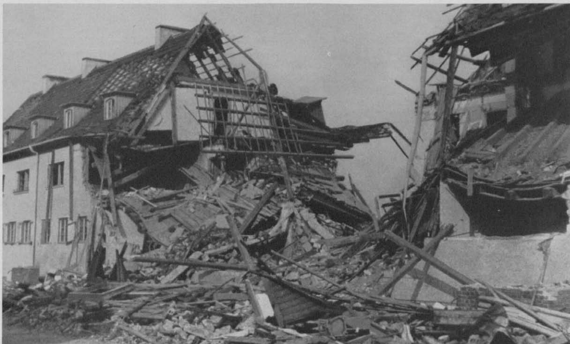
Bombenruine in der Vogelweidesiedlung
