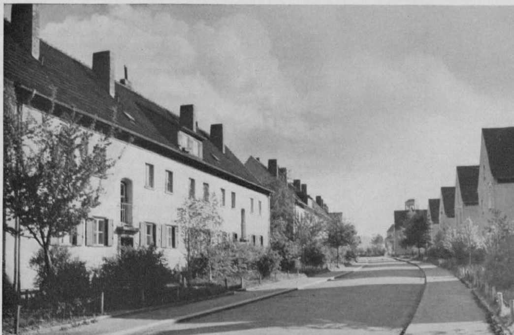
Die Fritz-Holter-Straße in der Vogelweidesiedlung
