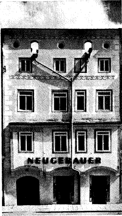
Abb. 14. Restaurierte Fassade des Hauses Stadtplatz 19 (zu S. 112)
