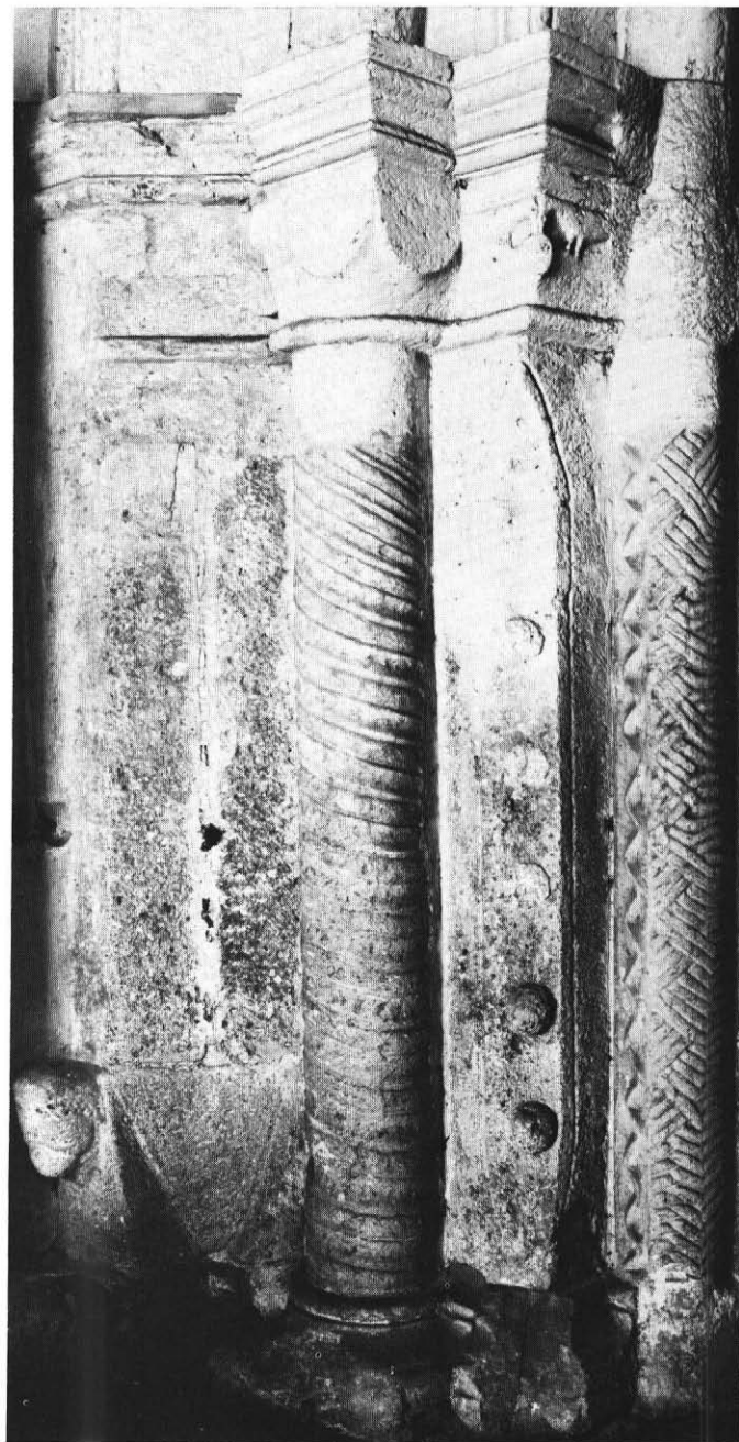
Das nördliche Gewände dieses Portals
