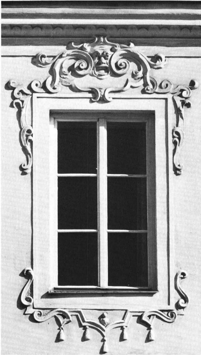
Fensterumrahmung am Hause Stadtplatz Nr. 5 (um 1720).
