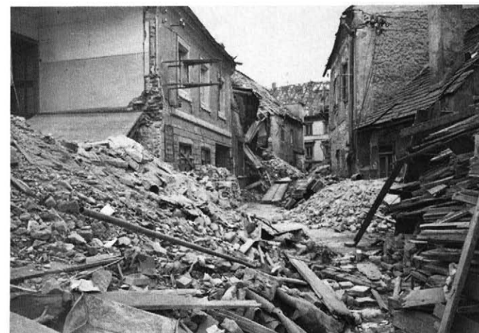
Bombenschäden am Bahnhof (oben), in der Vogelweide (Mitte), in der Almgasse (unten).
