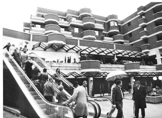
Einkaufszentrum Traunpark (1982). Architekturbüro Fred Achammer.
