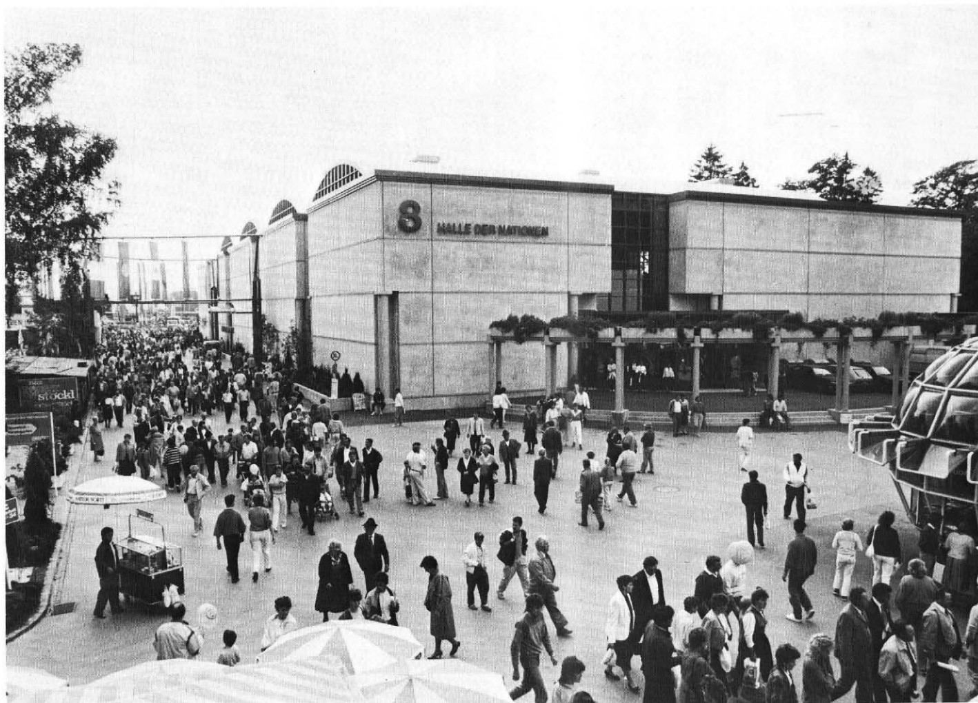
Welser Messe: Die 1986 errichtete „Halle der Nationen“.
