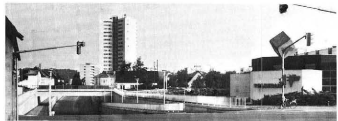
Unterführung Wimpassingener Straße (1982).
