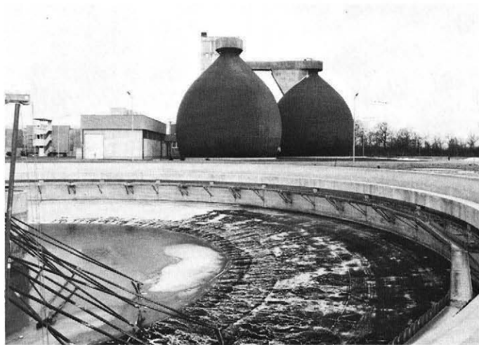
Kläranlage des Abwasserverbandes Welser Heide in Kappern-Marchtrenk (1985).
