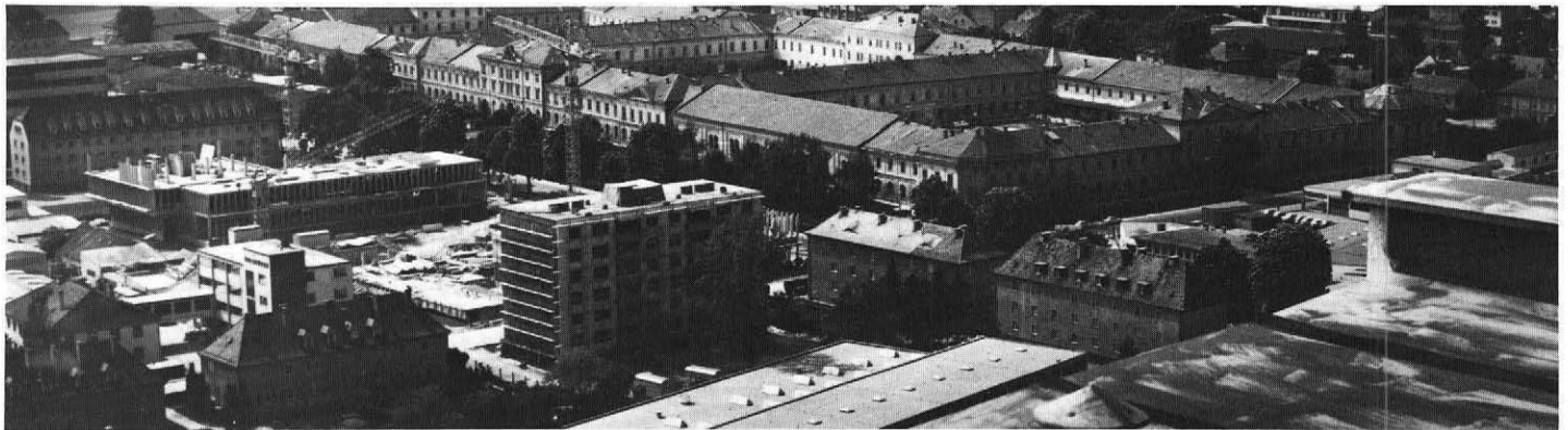
Bundesamtsgebäude gegenüber der ehemaligen Dragoner-Kaserne im Bau (1976).
