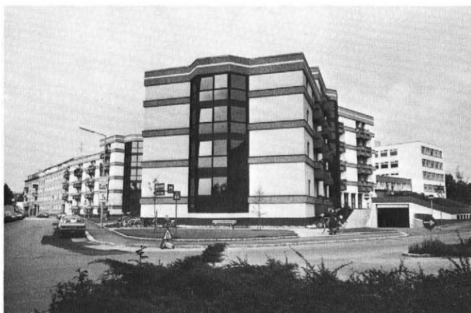
Pensionistenheim der Stadt Wels. Ausbau 1983, errichtet von der LAWOG.
