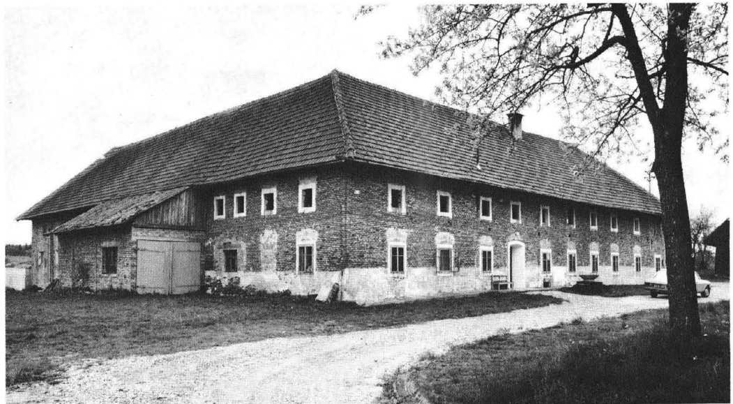
Vierkanter in Ziegelbau, 2. Hälfte 19. Jh., Sipbachzell, Permannsberg Nr. 15
