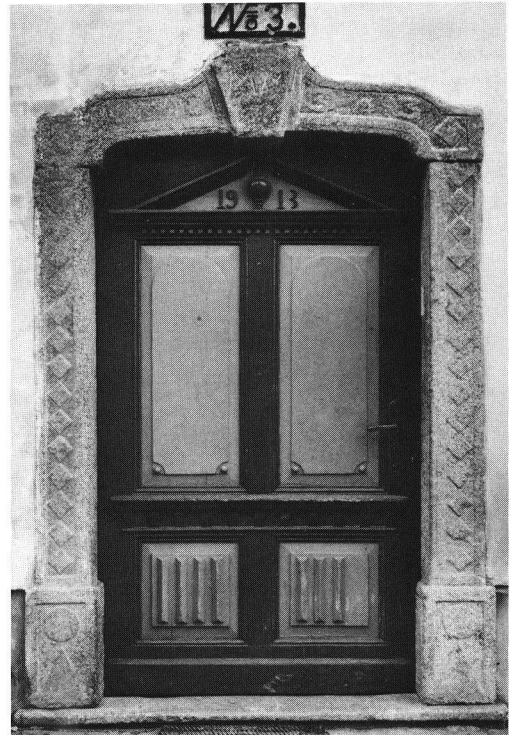
Türumrahmung in Granit, 1833 Historistische Holztüre 1913. Marchtrenk, Unterneufahrn Nr. 3
