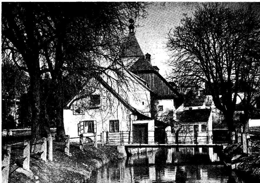
Abb. 4: Das malerische Ensemble Fabrikstraße 7, ehemals eine Weißgerberwerkstatt (abgerissen).
