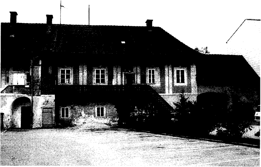
Abb.1 Ehemaliges Gebäude Dr. Koss-Straße 4-6.
