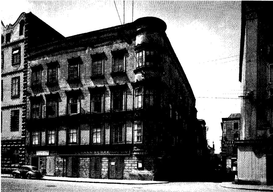
Abb.1 Wels, Stadtplatz Nr. 38 / Schmidtgasse Nr.1, Ansicht (Zustand um 1960)
