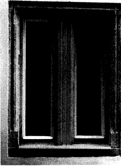
Abb. 6 Wels, Stadtplatz Nr. 38 /Schmidtgasse Nr. 1, spätgotisches Fenstergewände an der Westseite des Hofes, zweites Obergeschoß, um 1520 (Zustand 1970)
