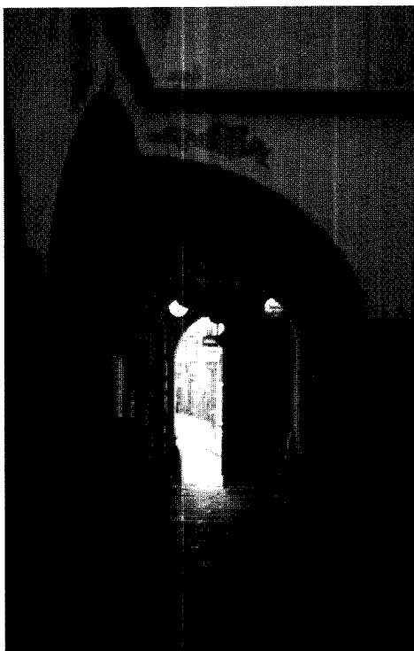
Abb. 10 Linz, Altstadt Nr. 2, Losensteiner Freihaus, Hofecke mit Blick in die Einfahrt (Zustand 1998)
