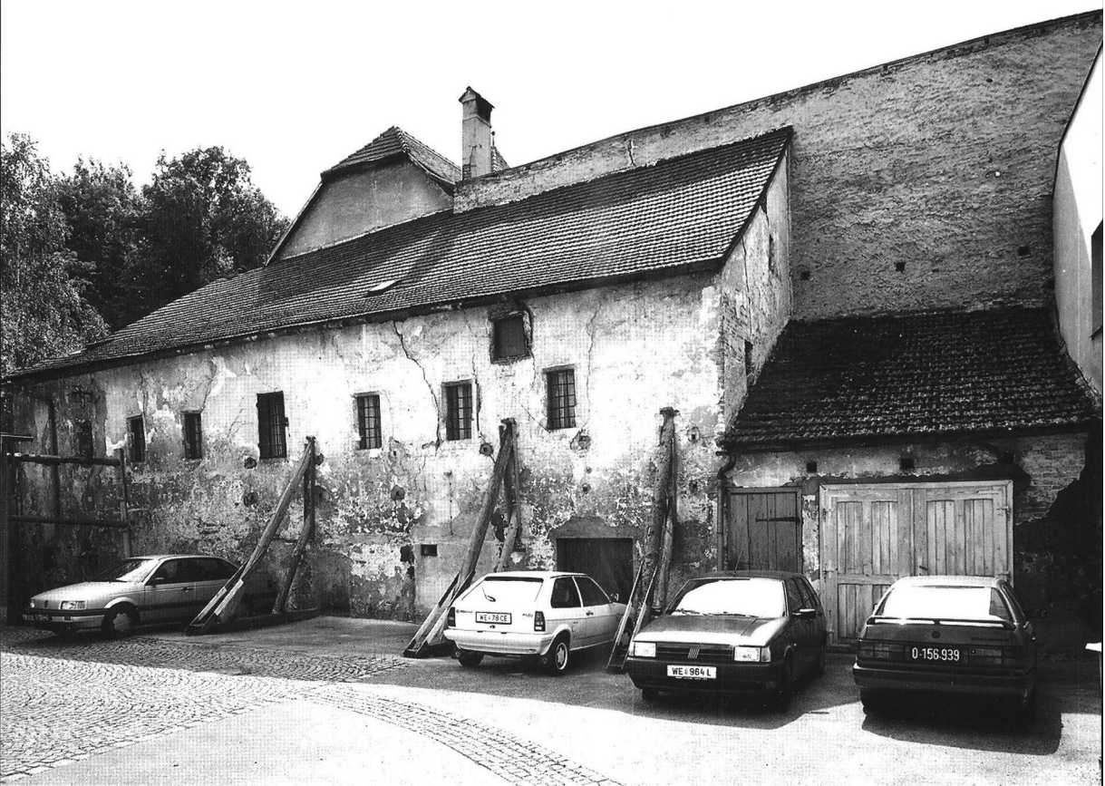
Abb. 7 Ehem. Wirtschaftstrakt des 16. Jhts. im Schießberhof, Vorzustand (1993).
