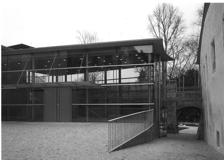
Abb. 3 Foyer EG. Innenaufnahme, Abb. 4 Foyer Schießberhof, Durchgang zum Zwinger. Rechte Seite: Abb. 5 Foyer Gang an der Stadtmauer, Abb. 6 Foyer Höhengsprung Galerie- erschließung, Abb. 7 Außenansicht vom Zwinger mit Stadtmauer und Wasserturm
