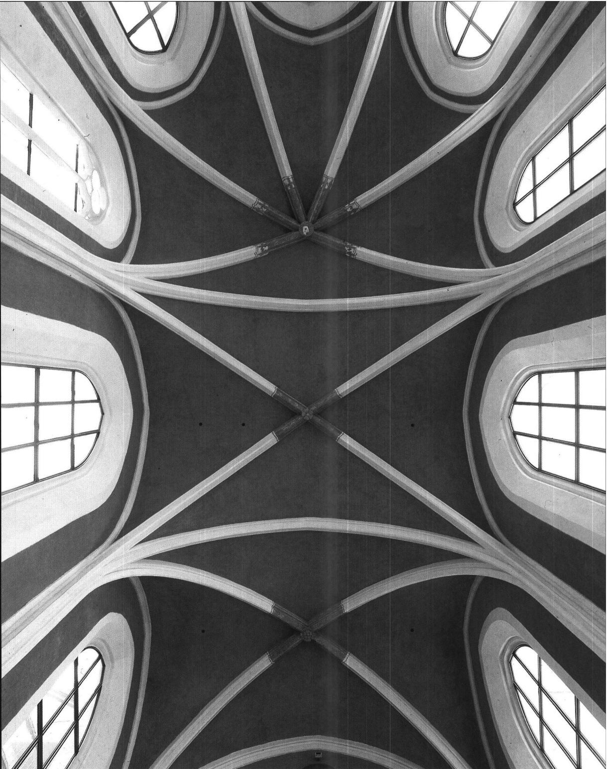
Abb. 2 Kreuzrippengewölbe des Chores
