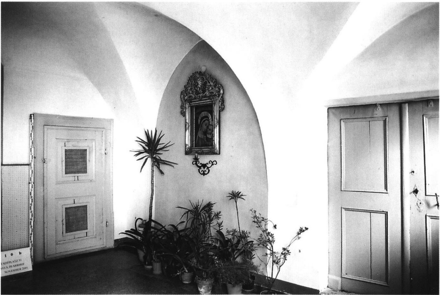
Abb. 12 Hauptgebäude, Raum 0.10, Vorhaus, Blickrichtung Südosten, links ein originales Türblatt mit geohrter Bekleidung aus der Zeit der Errichtung der innen liegenden Stiege, Mitte 18. Jahrhundert.
