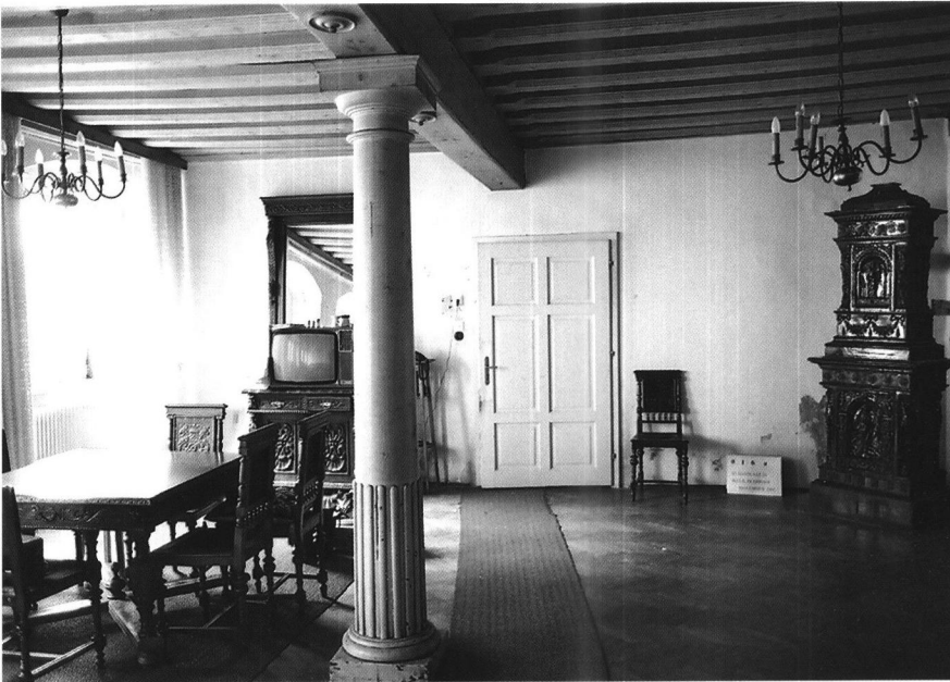
Abb. 13 Hauptgebäude, Raum 0.16, Speisezimmer mit frühneuzeitlicher Balkendecke, die Säule wurde erst im 19. Jahrhundert eingestellt.
