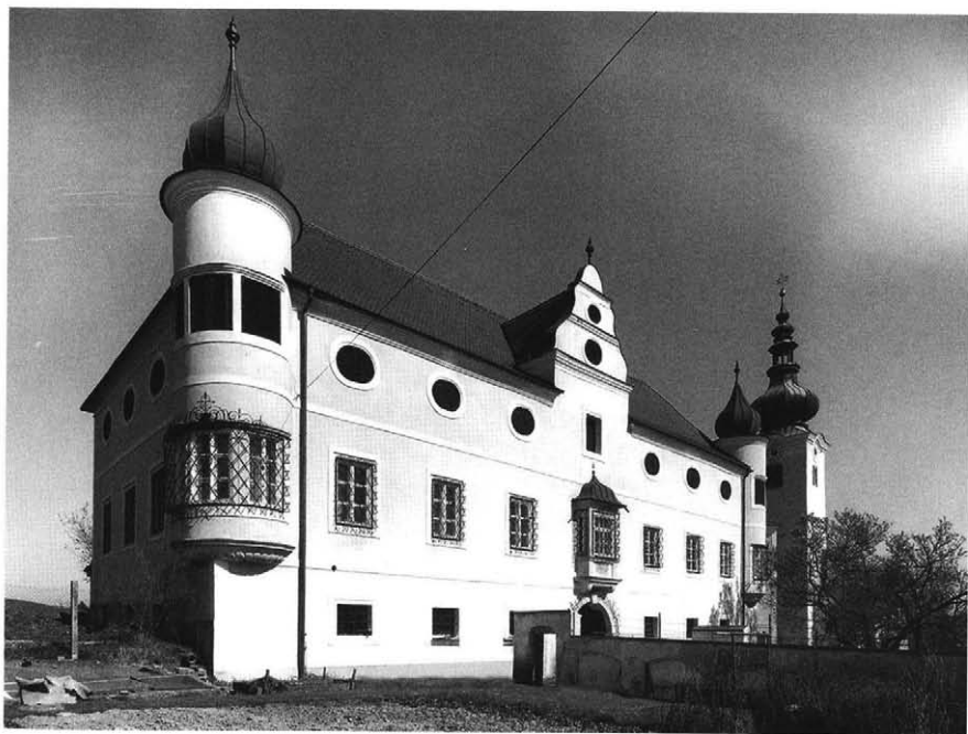
Abb. 5 Pfarrhof Buchkirchen, Ansicht von Südwesten
