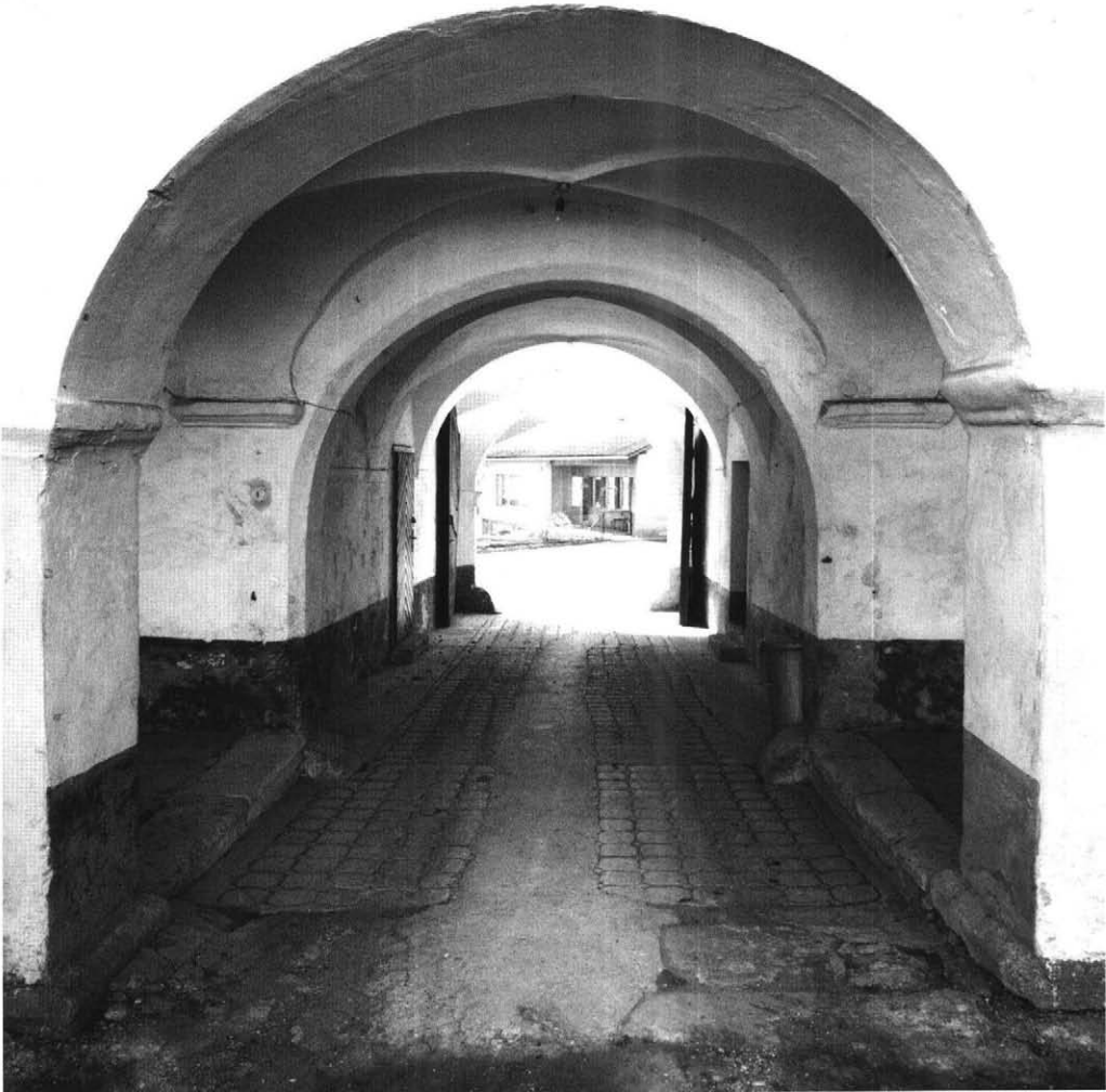
Abb. 19 Pfarrhof Buchkirchen, Südtrakt, Blick in die Durchfahrt
