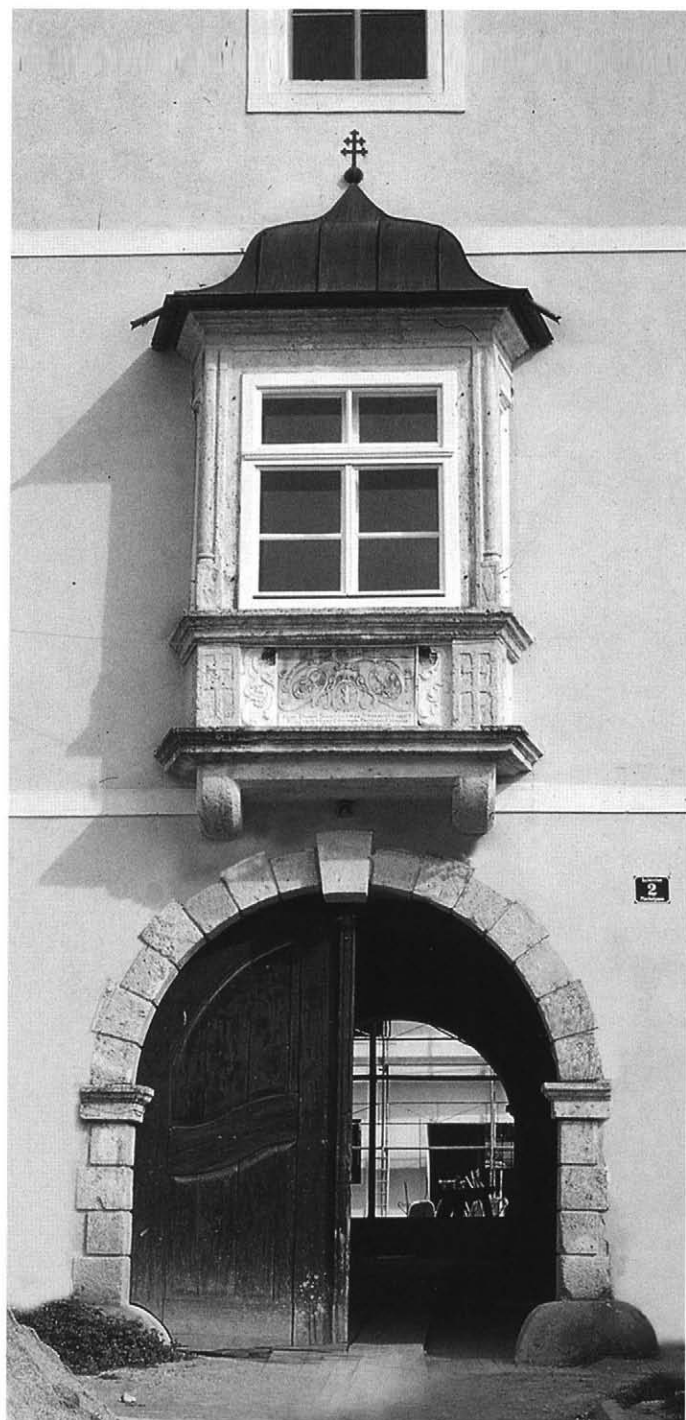
Abb. 20 Pfarrhof Buchkirchen, Südfront, Detail: Portal und Erker
