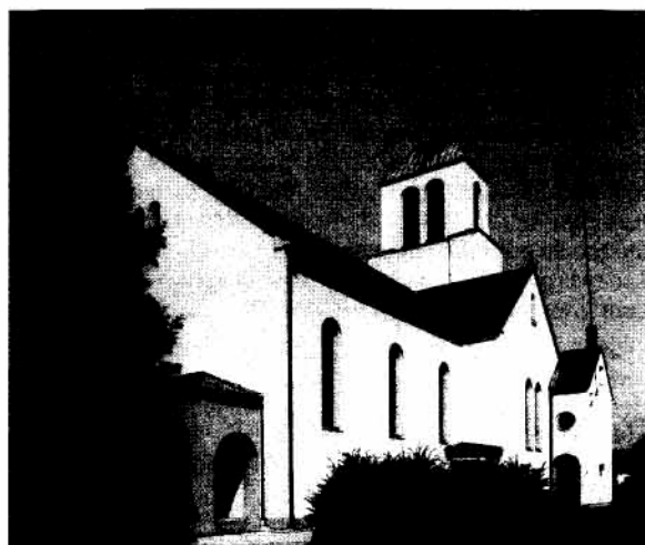
Abb. 8: Die „alte“ Severin-Kirche in der Katzenau (1935–1937 errichtet).
