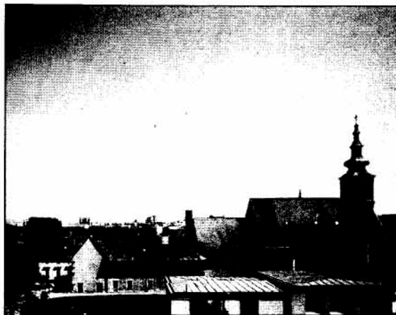
Abb. 17: Die Stadtpfarre Urfahr wurde 1784 beim ehemaligen Kapuzinerkloster errichtet.
