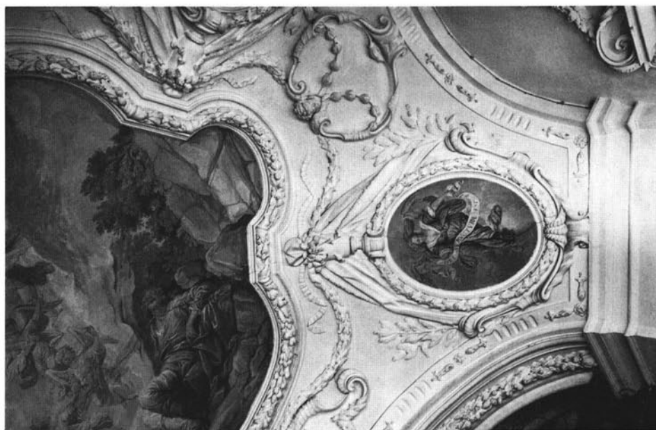
Abb. 22 Kremsmünster, Inneres der Stiftskirche, Gewölbedetail der Vorhalle
